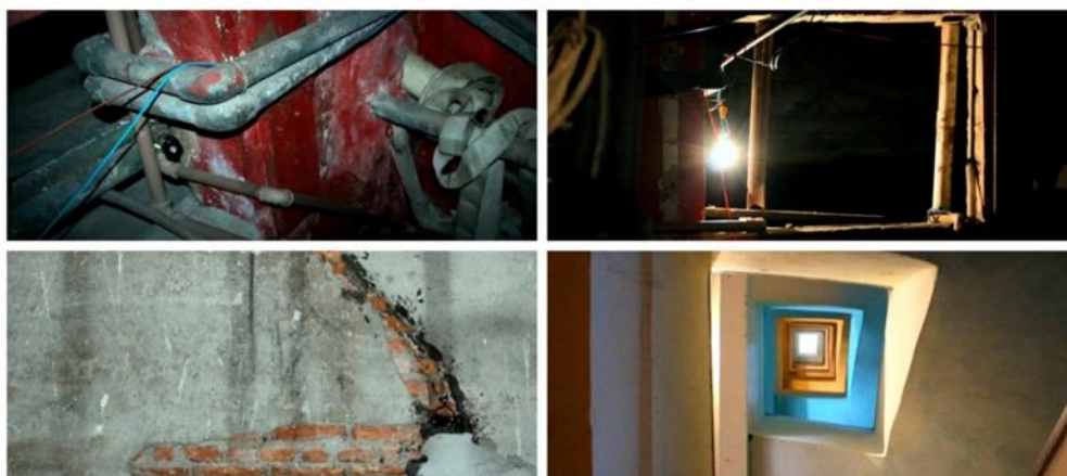
Figura 1 – Aparição estrutural do Cambridge, entre a reforma e a demolição
