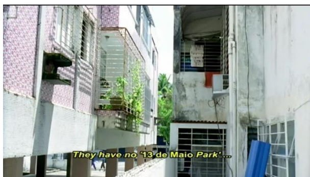
Figura 5 – Janelas com grades.
